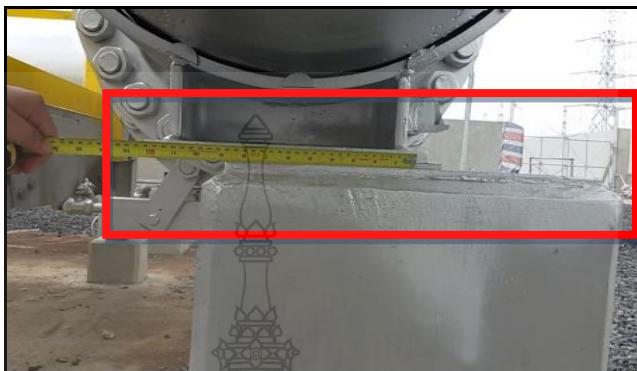
รูปที่ 3.25 บอกรับตำแหน่งตัวรองรับไม่ตรงกับแบบโยธา (GA5)
