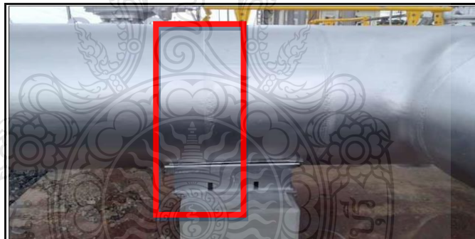
รูปที่ 3.21 วางตัวรองรับตรงกับแนวเชื่อมของท่อ (GA9)
