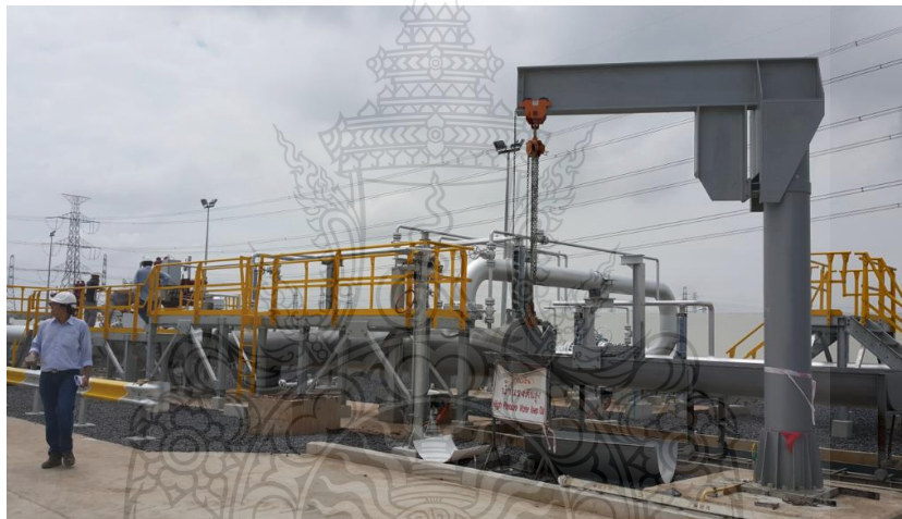
รูปที่ 3.2 ตัวอย่างงานสร้างสถานีลดความดันก๊าซหลังจากการออกแบบท่อ
