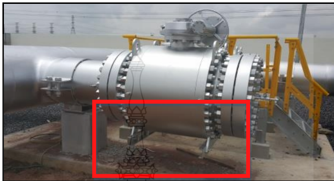
รูปที่ 3.28 ออกแบบตัวรองรับไม่เหมาะสมกับการออกแบบท่อ (SA21)
