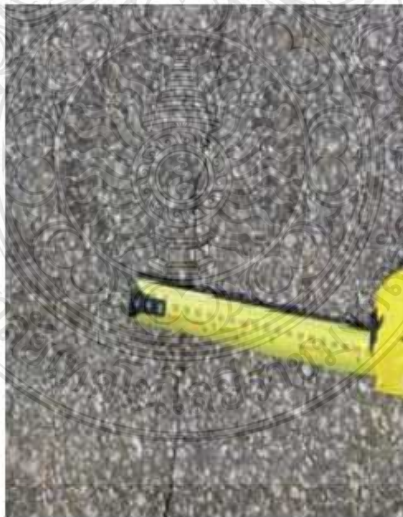
รูปที่ 2.7 รอยแตกแบบสะท้อนที่มีลักษณะแคบ (น้อยกว่า 3 มิลลิเมตร) [24]
