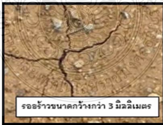
รูปที่ 4.12 สภาพผิวของชั้นพื้นทางดินซีเมนต์ที่เกิดความรุนแรงจนเป็นเหตุให้ชั้นพื้นทางเสียหาย
