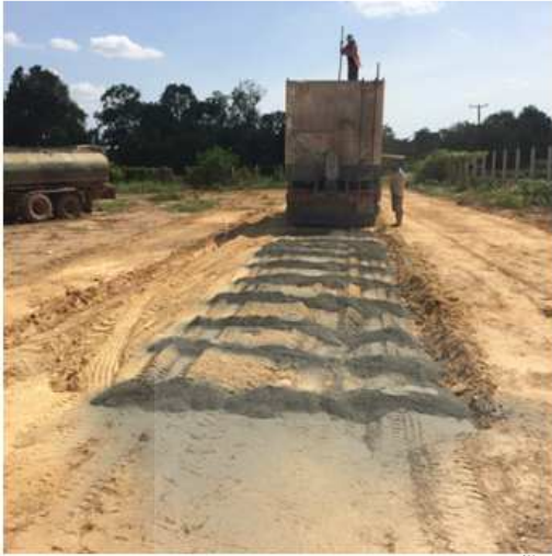
รูปที่ 3.9 การปล่อยปูนซีเมนต์ในแปลงทดสอบ
