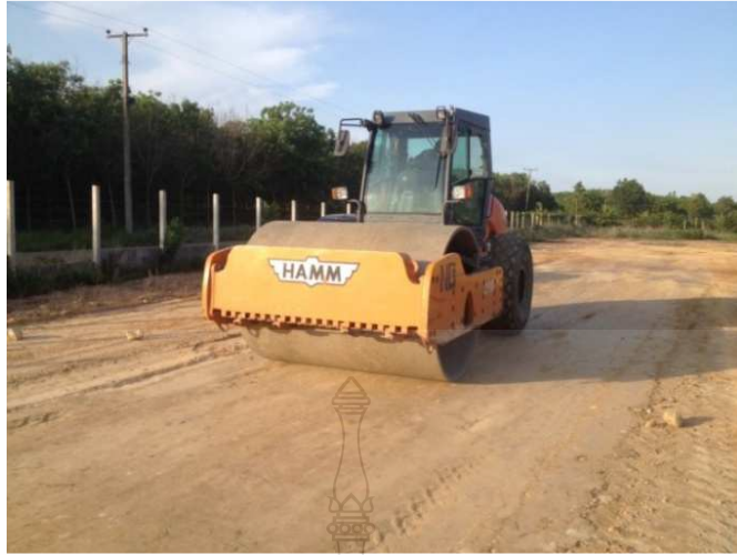
รูปที่ 3.15 กระบวนการสร้างรอยร้าวขนาดเล็ก
