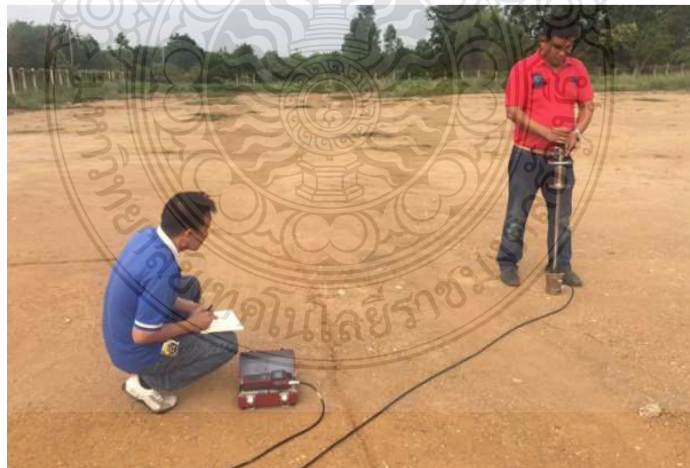
รูปที่ 3.17 การทดสอบความแข็งแรงพื้นที่ทางด้วย LWD
