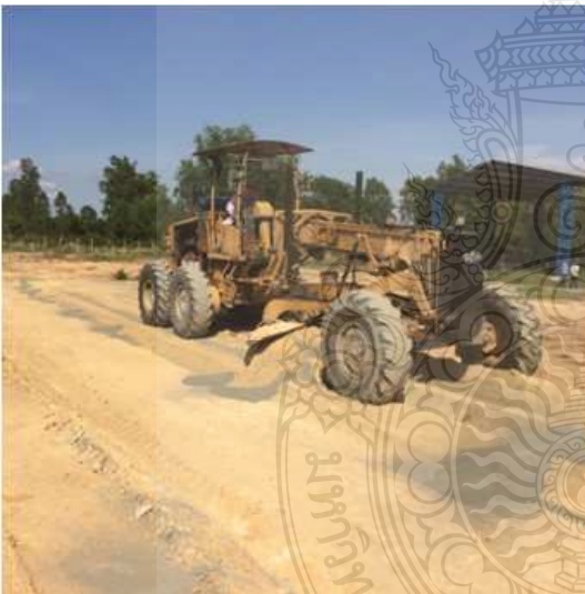
รูปที่ 3.10 การผสมแห้งเพื่อคลุกเคล้าให้เข้ากัน
