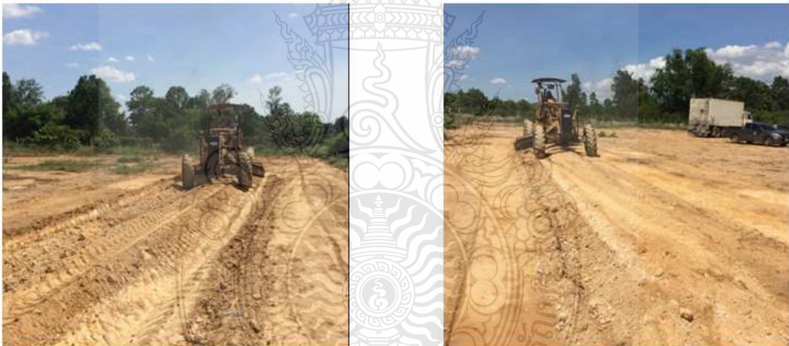
รูปที่ 3.8 การเกรดและบดอัดดินลูกรัง
