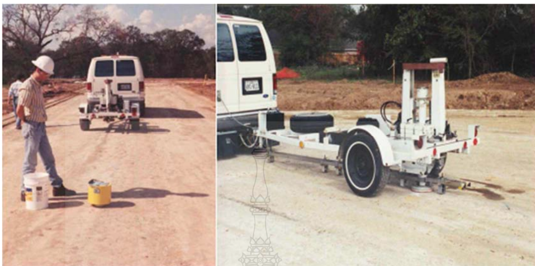
รูปที่ 2.2 การตรวจสอบความแข็งแรงในชั้นพื้นทางดินซีเมนต์ในงานศึกษาของ Scullion [16]
