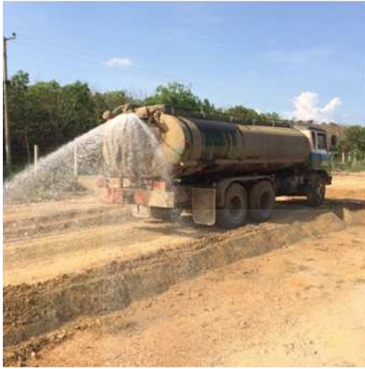
รูปที่ 3.11 การผสมแบบเปียก
