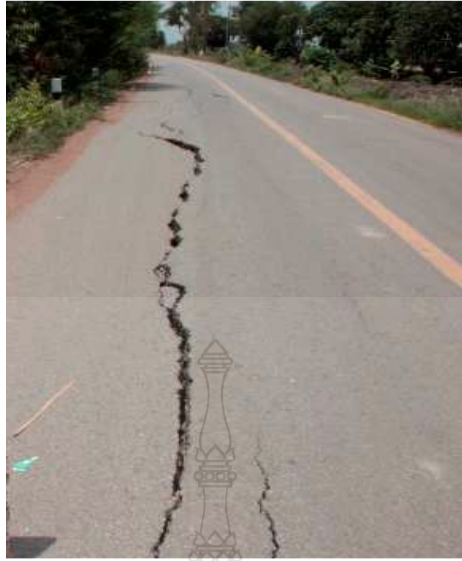
รูปที่ 2.8 รอยแตกแบบสะท้อนที่มีลักษณะกว้าง(มากกว่า 3 มิลลิเมตร) [24]
