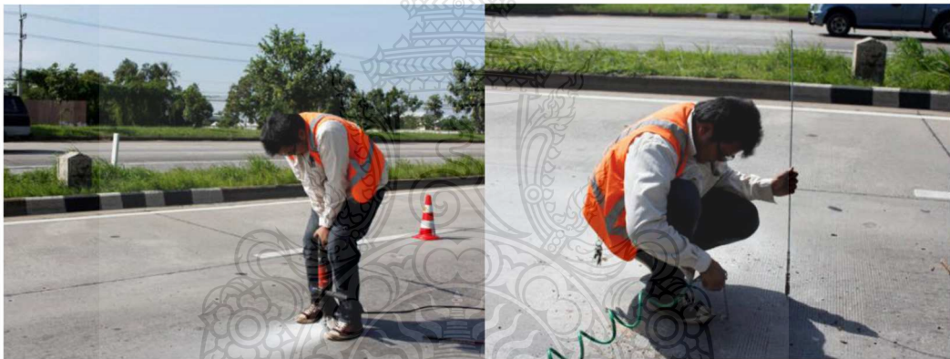
รูปที่ 4.1 เจาะสำรวจหาความหนาชั้นทางถนนคอนกรีตสายทางสระบุรี – หนองแค (SN)
