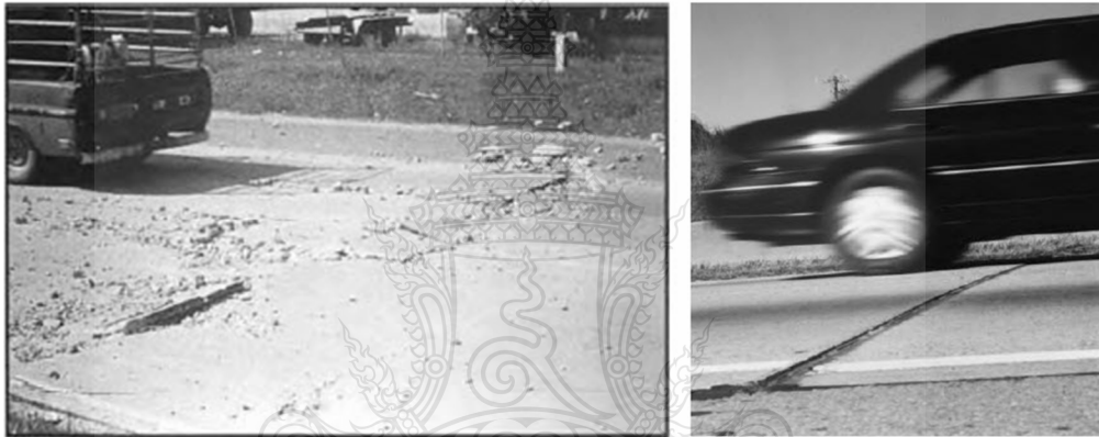
รูปที่ 2.6 ความเสียหายจากการคั้งหรือโก่งตัว (ซ้าย) การทรุดตัวที่ไม่เท่ากันของรอยต่อ (ขวา) [5]
