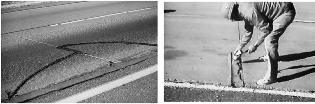
รูปที่ 2.5 ความเสียหายจากการแตกหักที่มุมแผ่น (ซ้าย) การแตกหลุดร่อนที่รอยต่อตามขวาง (ขวา) [5]
