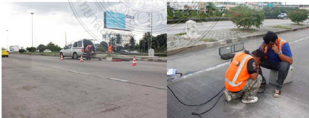
รูปที่ 4.2 เจาะสำรวจหาความหนาชั้นทางถนนคอนกรีตสายทางปทุมธานี – ชนบุรี (PT)
