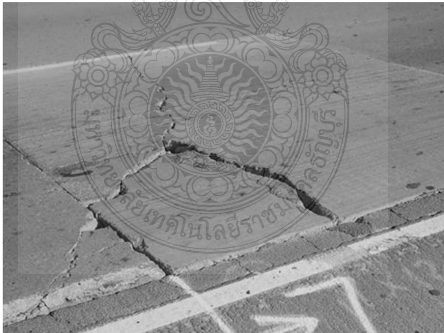
รูปที่ 1.1 ความเสียหายที่เกิดจากโพรงใต้แผ่นพื้นคอนกรีต [8]
