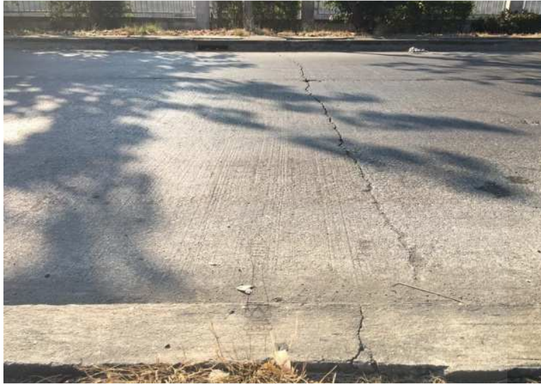
รูปที่ 1.1 รอยร้าวตามขวางในผิวทางคอนกรีต
