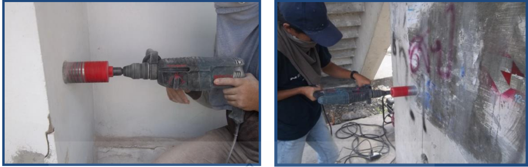
รูปที่ 3.8 การเจาะเก็บตัวอย่างคอนกรีตด้วยส่วนหัวเจาะแบบ Hole Saw
