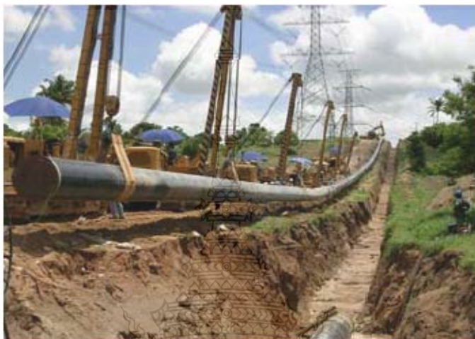
ภาพที่ 2.18 การวางท่อส่งปีโตรเลียมใต้ดินโดยการเปิดผิวดิน [21]
