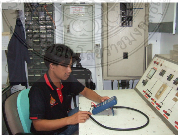
ภาพที่ 3.2 การวัดค่าพารามิเตอร์ของสายไฟฟ้าวงจรป้องกันท่อสุกร่อน
