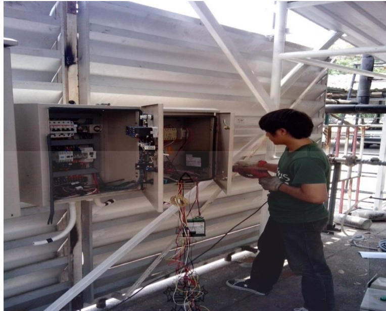
รูปที่ ข.7 ติดตั้งชุดควบคุมกระแสไฟฟ้า (24 กุมภาพันธ์ 2557)
