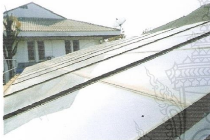
รูปที่ 2 แผงเซลล์แสงอาทิตย์ที่ทำงานร่วมกับแผงผลิต น้ำร้อนพลังงานแสงอาทิตย์แบบเรียบที่ใช้ในการศึกษา
