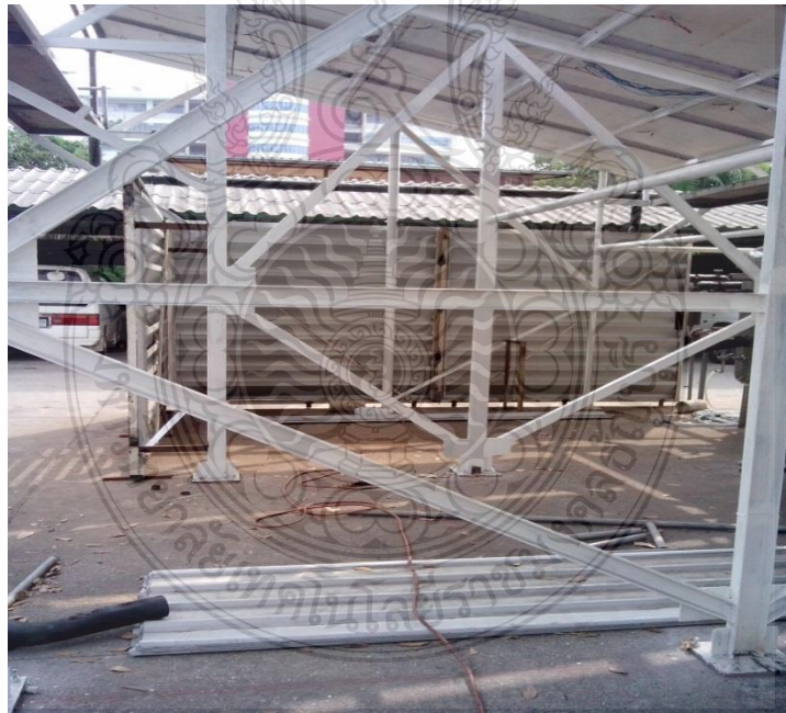
รูปที่ ข.6 สร้างห้องควบคุมกระแสไฟฟ้า (17 กุมภาพันธ์ 2557)
