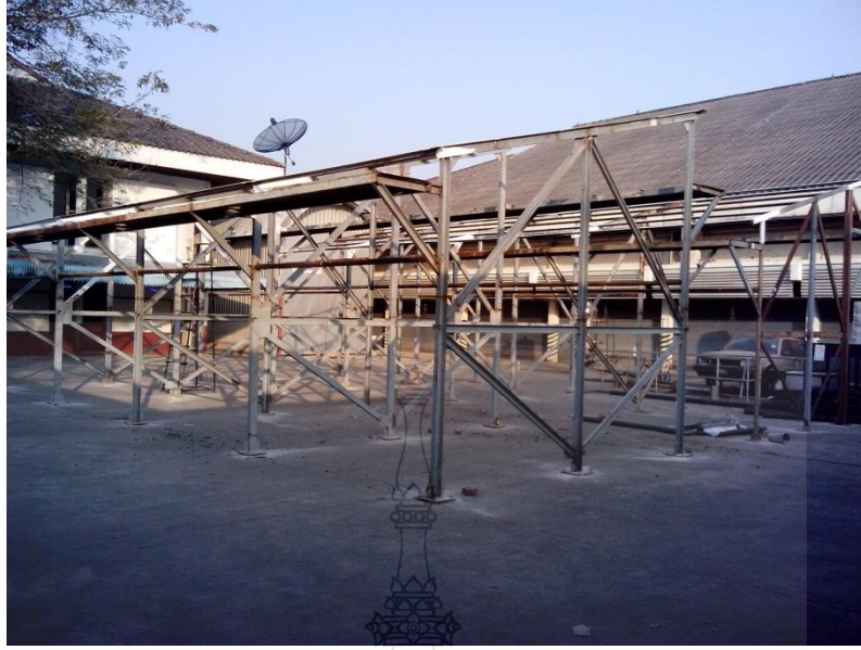
รูปที่ ข.3 ติดตั้งโครงสร้าง (30 ธันวาคม 2556)
