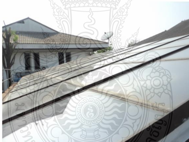
รูปที่ 3.5 แผงเซลล์แสงอาทิตย์ที่ทำงานร่วมกับแผงผลิตน้ำร้อนพลังงานแสงอาทิตย์แบบเรียบ
