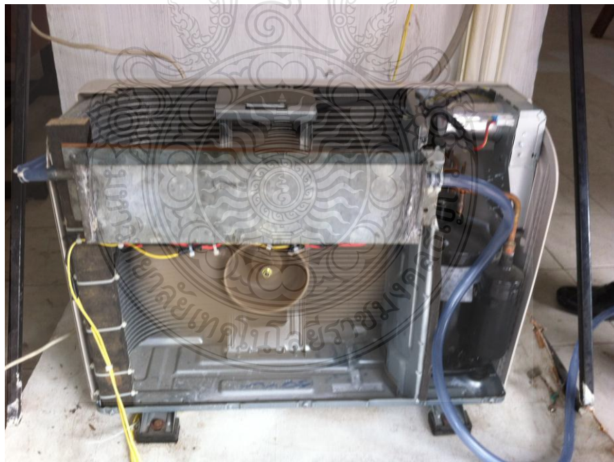
ภาพที่ 3.24 บันทึกและเก็บข้อมูลการทดสอบอุณหภูมิชุดคอนเดนเซอร์เครื่องปรับอากาศแบบแยกส่วนขณะที่เครื่องปรับอากาศทำงาน
