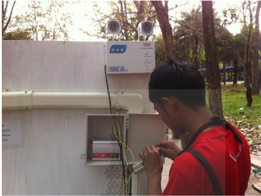
ภาพที่ 3.18 เดินสายไฟฟ้าอุปกรณ์ควบคุมชุดผลิตไฟฟ้าด้วยโมดูลเทอร์โมอิเล็กทริก
