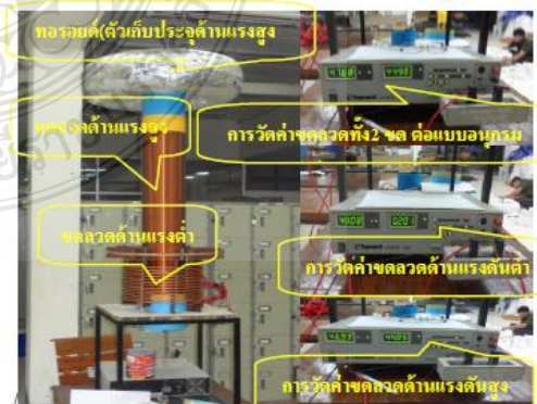
รูปที่ 4 การวัดค่าพารามิเตอร์ต่างๆของหม้อแปลงเทสตา
