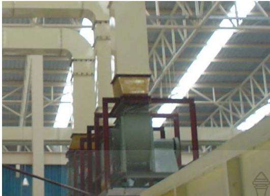
ภาพที่ 4.6 Hood ควบคุมความร้อนจุดปาทงเข้าห้องอบสี
