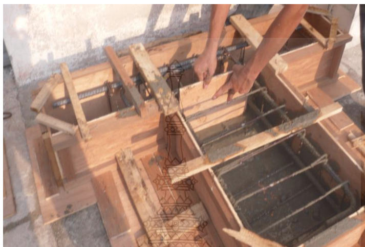
ภาพที่ 3.6 แบบหล่อพร้อมเหล็กเสริมที่จะเทคอนกรีต สำหรับตัวอย่างเสา-คานคอนกรีตเสริมเหล็ก
