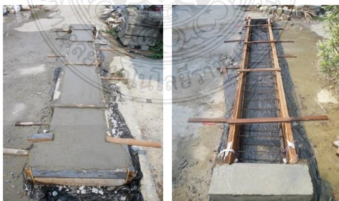
ภาพที่ 3.13 แท่งตัวอย่างการเทคอนกรีตเสา - คานแบบต่อเนื่องและไม่ต่อเนื่อง
