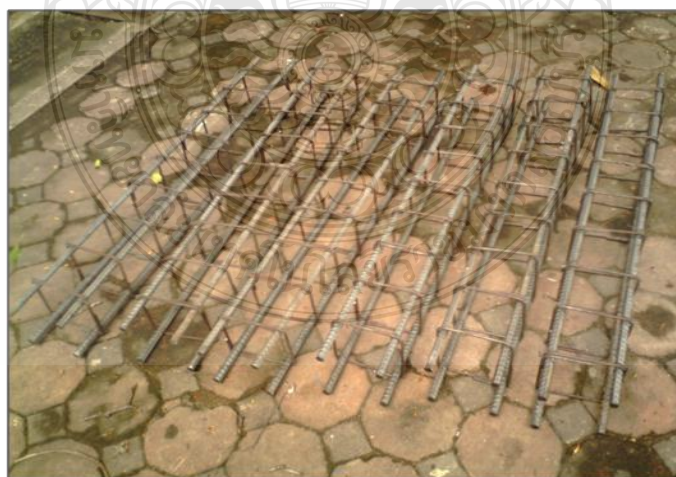
ภาพที่ 3.5 การผูกเหล็กปลอกเสากับเหล็กแกนเสา
