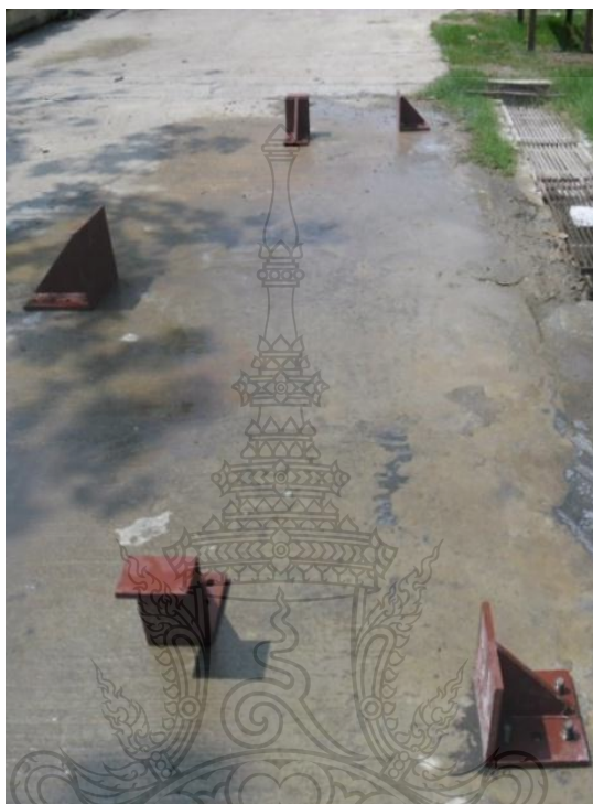
ภาพที่ 3.20 จูกรองรับที่ยึดติดเรียบร้อยแล้วทั้งสองด้าน
