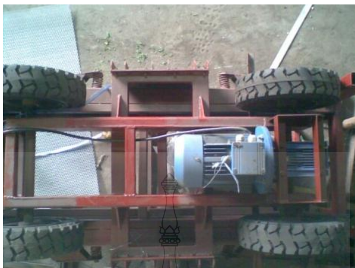
ภาพที่ 3.5 การติดตั้งมอเตอร์ไฟฟ้า 3 เฟสในรถไฟฟ้า
