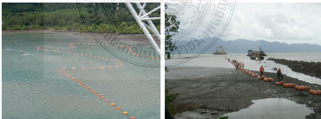
ภาพที่ 3.3 การวางสายเคเบิลใต้น้ำช่วงขึ้นฝั่งไปยังเกาะช้าง
