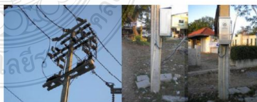
รูปที่ 1 ลักษณะการติดตั้งมิเตอร์อ่านหน่วยอัตโนมัติ
