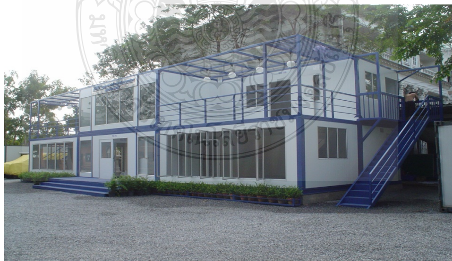
ตู้คอนเทนเนอร์แบบสำนักงานเคลื่อนที่ (Mobile Container)
