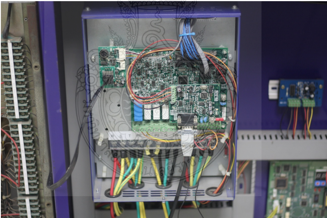
5. ชุดขับเคลื่อนกำลังของลิฟต์
