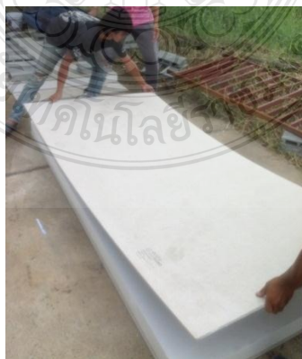
รูปที่ 3.10 ประกบแผ่นไฟเบอร์ซีเมนต์บนแผ่นโฟมที่ทำด้วยกาว Poly Coat
