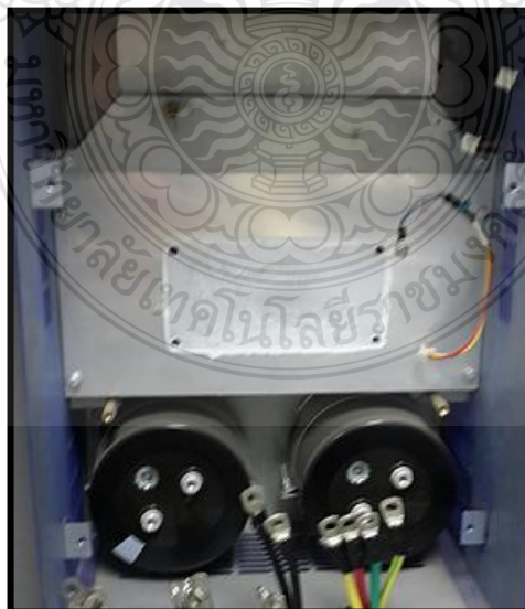
รูปที่ 3.4 ขนาดตัวเก็บประจุ [ 3,300 \mu F 400v ]
