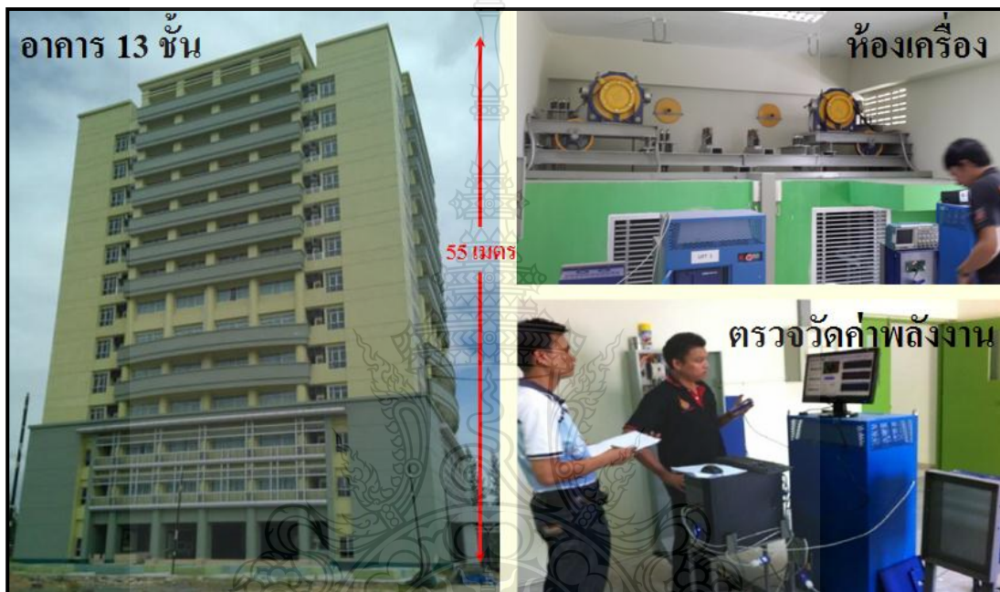
รูปที่ 4.7 อาคาร 13 ชั้นที่ติดตั้งชุดควบคุมกำลังไฟฟ้า ERU และทำการตรวจวัดค่าพลังงาน
