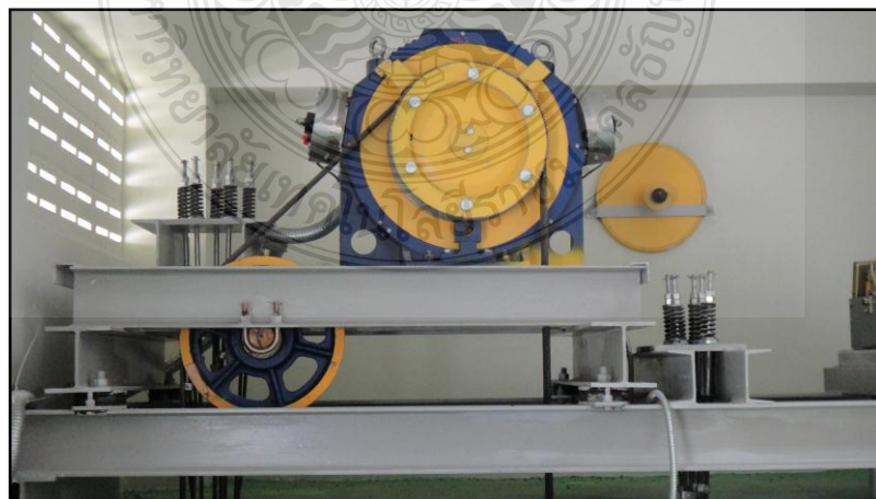
รูปที่ 2.5 ล้อสายพาน (Sheave) และมอเตอร์แบบแม่เหล็กถาวร
