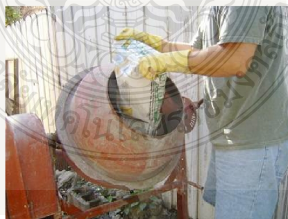
รูปที่ 2.13 การผสมสารยับยั้งการเกิดสนิมลงในคอนกรีต
