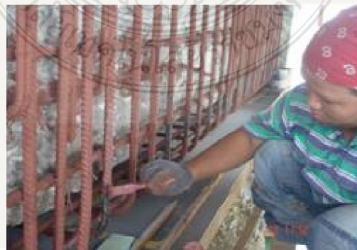
รูปที่ 2.15 การทาสารยับยั้งการเกิดสนิมที่ผิวของเหล็กเสริม
