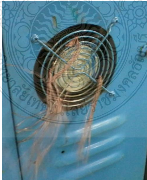
รูปที่ 2.8 การตรวจสอบการทำงานของใบพัดระบายความร้อน
