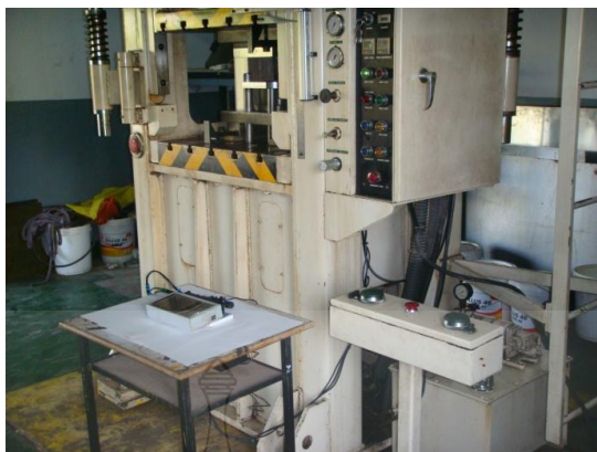
รูปที่ 6 การติดตั้งอุปกรณ์จัดเก็บสัญญาณต่อเข้ากับเครื่องปั๊ม
