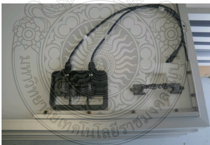
ภาพที่ 3.17 ติดตั้งกล่องรวมสาย (Junction Box)
