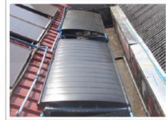
(ก) แผงน้ำร้อนพลังงานแสงอาทิตย์จากวัสดุโพลีเมอร์
