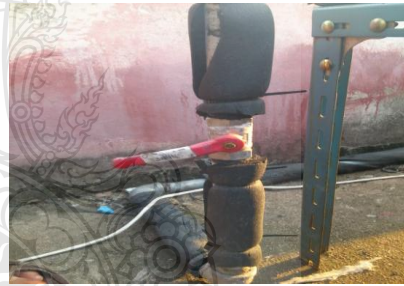
(ง) ทำการเปิดน้ำเข้าแผงดูดซับความร้อน
