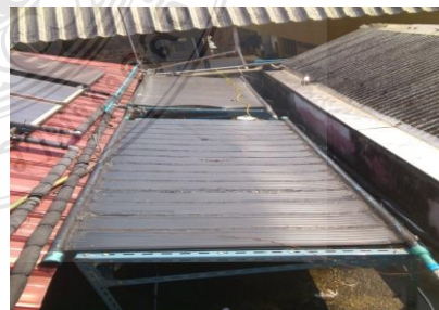
(ฉ) การติดตั้งแผงดูดซับความร้อนพลังงานแสงอาทิตย์
