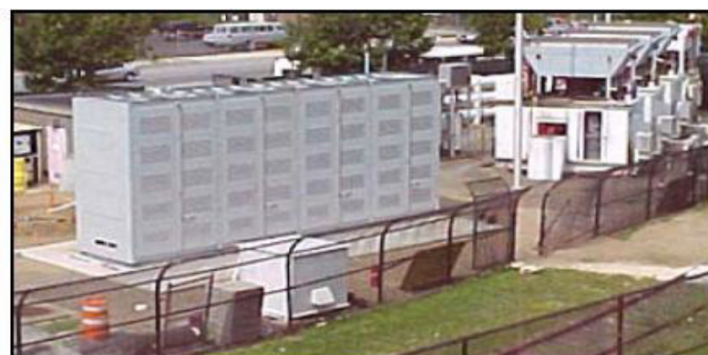
ภาพที่ 2.44 แบตเตอรี่โซเดียมซัลเฟอร์ขนาด 1.2 MW/7.2 MWh โดย NYPA [24]
