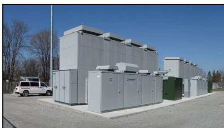
ภาพที่ 2.43 สถานีย่อยของ American Electric Power (AEP) เก็บและจ่ายพลังงาน โดยแบตเตอรี่ชนิด โซเดียมซัลเฟอร์ [24]
