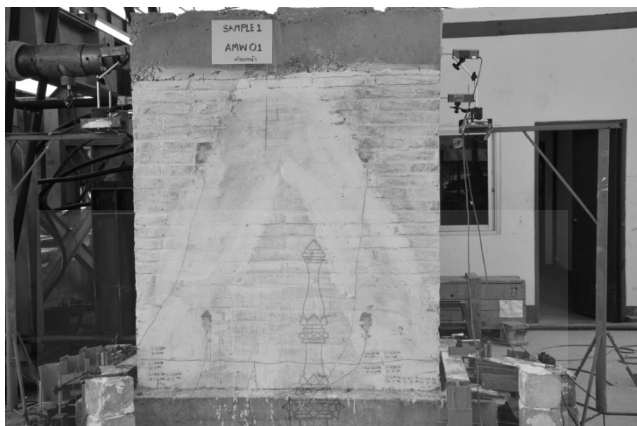
ภาพที่ ก.32 ผนัง AMW01 หลังการทดสอบ เกิดรอยร้าวรอบผนังบริเวณสูงจากฐานคอนกรีตเสริมเหล็กประมาณ 20 ซม.
