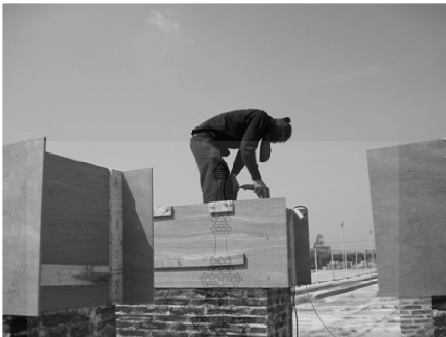
ภาพที่ ก.15 เทคานทับหลังคอนกรีตเสริมเหล็ก
