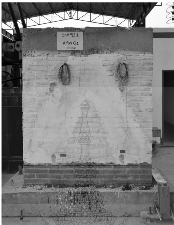
ภาพที่ ก.34 เตรียมผนัง AMW01_GFRP.A ซ่อมแซมรอยแตกร้าวด้วย GFRP
