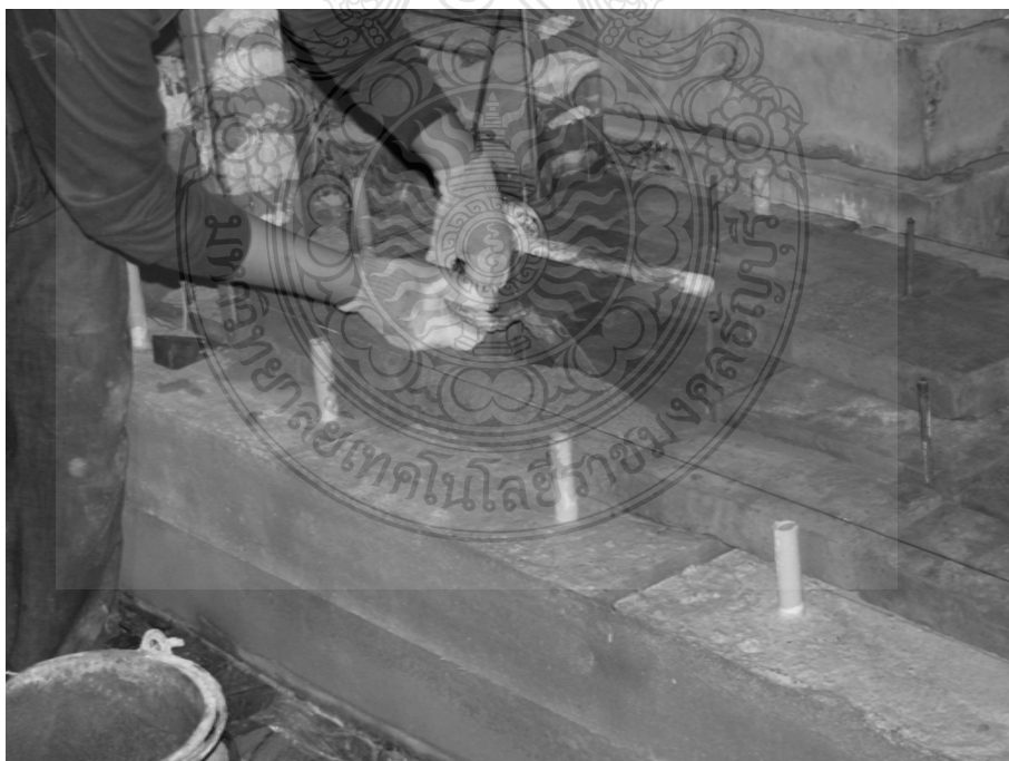
ภาพที่ ก.2 เตรียมผนังอิฐก่อโบราณตัวอย่างทดสอบ
