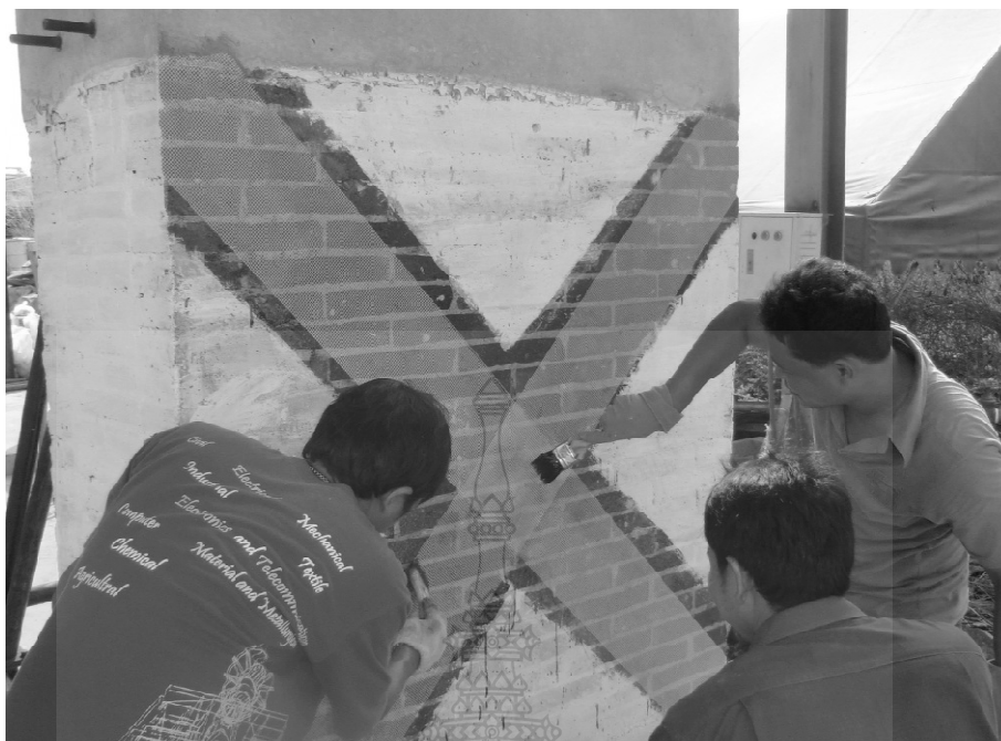
ภาพที่ ก.23 การติดตั้งเส้นใยไฟเบอร์
