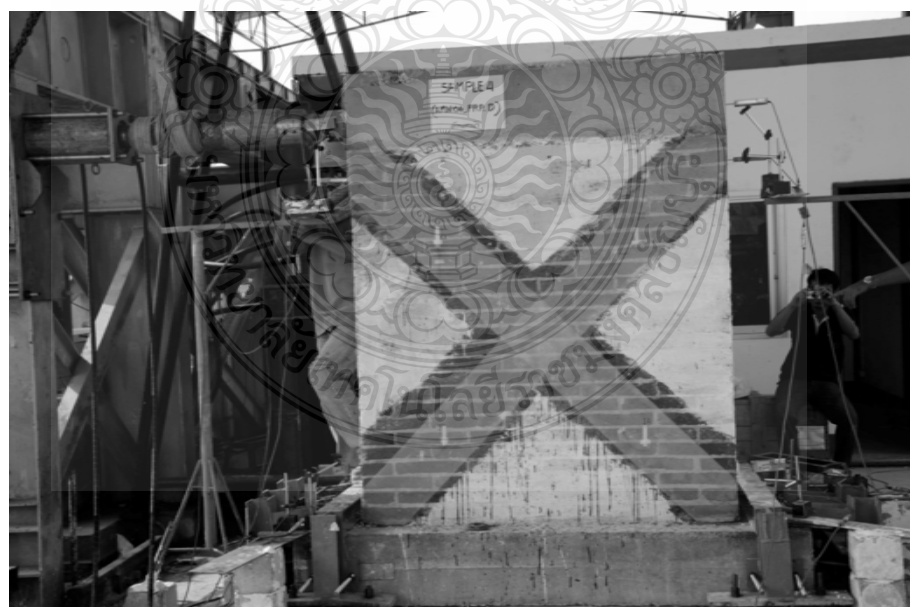
ภาพที่ ก.47 ติดตั้งอุปกรณ์เตรียมการทดสอบผนัง AMW04_GFRP.D
