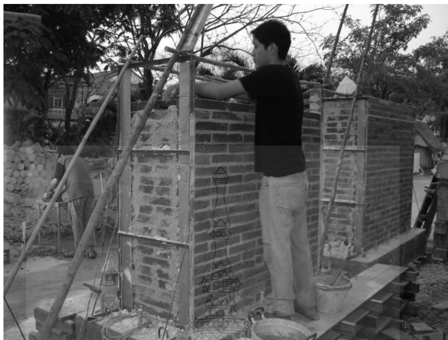
ภาพที่ ก.3 เตรียมผนังอิฐก่อโบราณตัวอย่างทดสอบ
