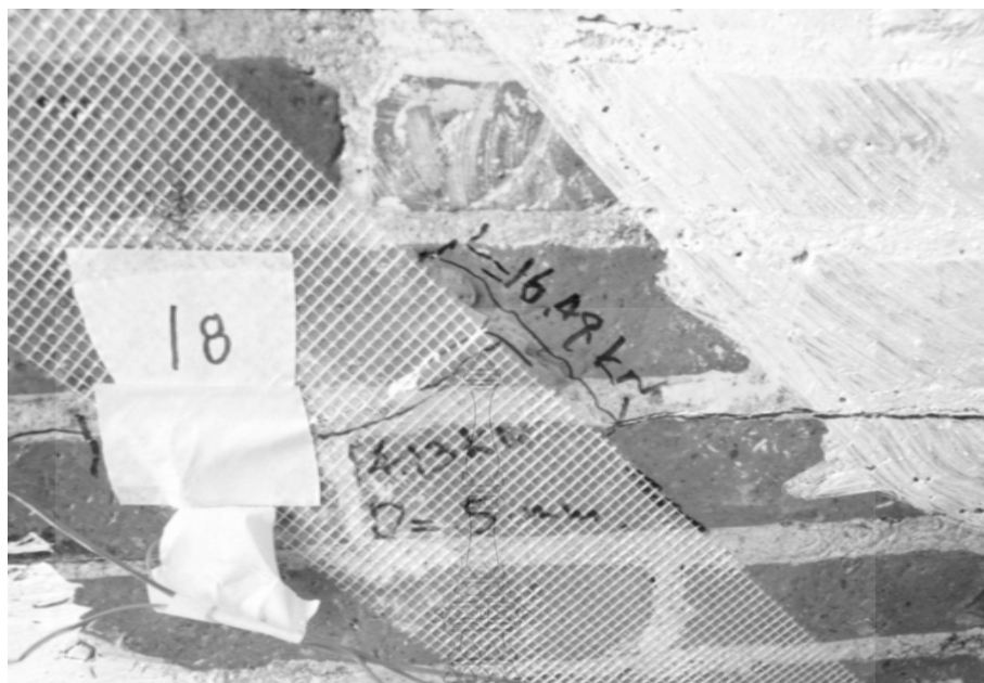
ภาพที่ ก.42 ทำการทดสอบผนัง AMW03_GFRP.C ขณะทำการทดสอบสังเกตความกว้างและความยาวของรอยแตกร้าวที่เกิดขึ้น
