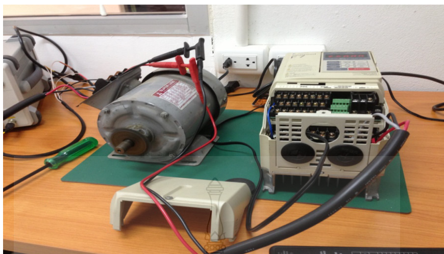
ภาพที่ 3.13 การใช้อินเวอร์เตอร์ควบคุมมอเตอร์เหนี่ยวนำ
