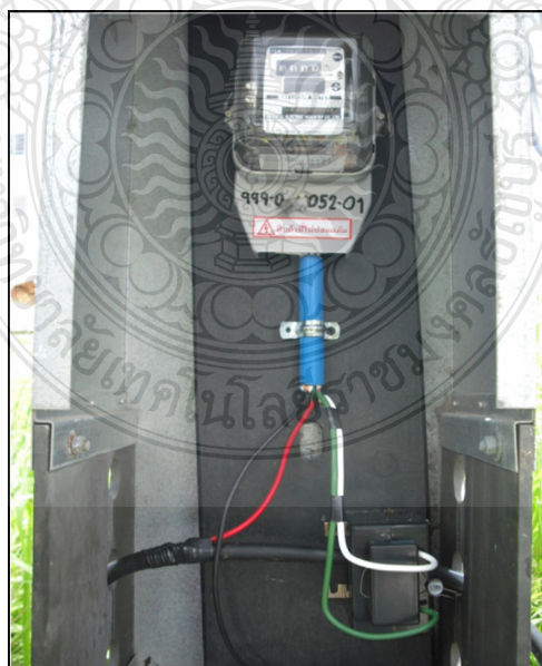
ภาพที่ 2.3 เครื่องวัดพลังงานไฟฟ้า 1 เฟส 2 สายประกอบหม้อแปลงกระแสแรงต่ำ
