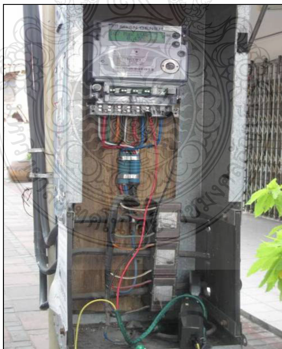
ภาพที่ 4.9 การวัดกำลังไฟฟ้าจริงเฟส C ด้วยแคลมป์ออนเพาเวอร์มิเตอร์
