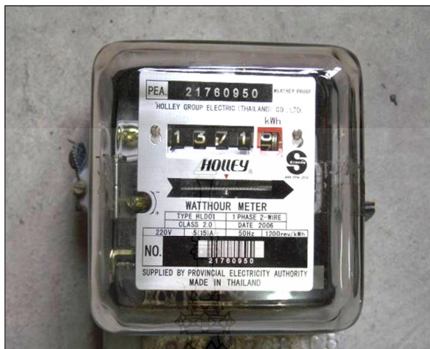
ภาพที่ 2.2 เครื่องวัดพลังงานไฟฟ้า 1 เฟส 2 สาย
