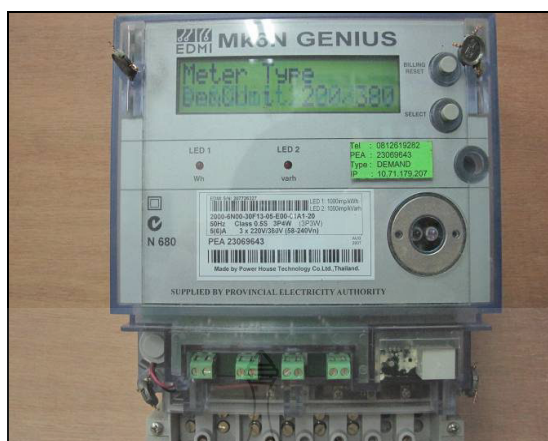
ภาพที่ 3.12 การติดตั้งเครื่องวัดพลังงานไฟฟ้าแบบอิเล็กทรอนิกส์บนแผงทดสอบ
