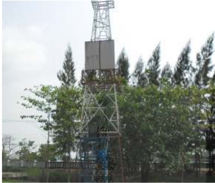
รูปที่ 3.9 เป้าหมายรังสีหอคอยแสงอาทิตย์ (solar tower)
