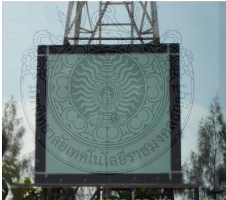
รูปที่ 3.10 งานปรับปรุงแผงรับรังสีหอคอยแสงอาทิตย์ (solar tower)
