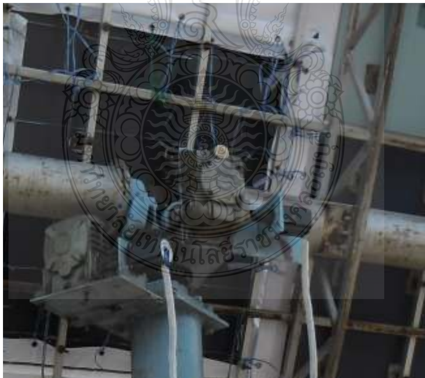
รูปที่ 3.8 การติดตั้งเตีปี่งมอเตอร์เพื่อส่งกำลังขับผ่านเกียร์ทดของแผงสะท้อนรังสีแสงอาทิตย์
