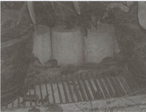
รูปที่ 6 การใช้แท่งตัวอย่างคอนกรีตกั้นดินไหลลงรางระบายน้ำ
