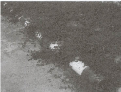
รูปที่ 7 การใช้แท่งตัวอย่างคอนกรีตกั้นทรายไหลลงถนน
