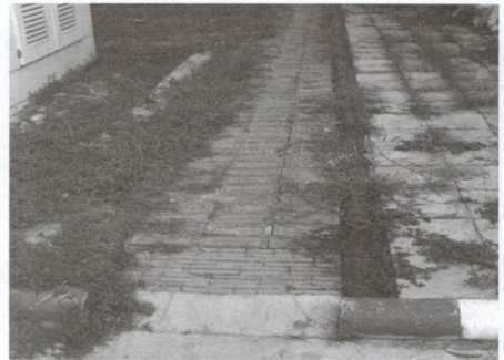
รูปที่ 8 การใช้แท่งตัวอย่างคอนกรีตทำขอบทางเดิน
