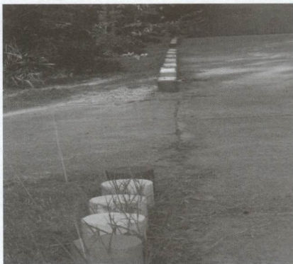
รูปที่ 13 การใช้แท่งตัวอย่างคอนกรีตทำขอบถนน
