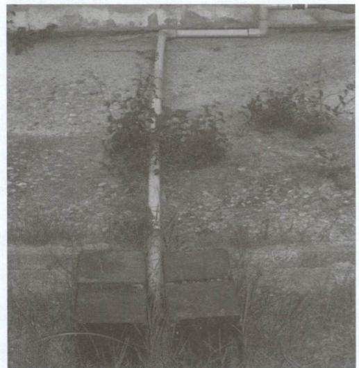
รูปที่ 15 การใช้ก้อนตัวอย่างคอนกรีตกันรถเหยียบจุดต่อของท่อน้ำพีวีซี
