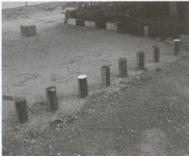
รูปที่ 11 การใช้แท่งตัวอย่างคอนกรีตทำที่กั้นไม่ให้รถยนต์ผ่าน
