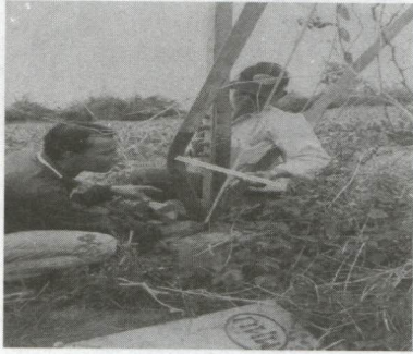
รูปที่ 8 การโค้งงอของเสาเนื่องจากถูกรถไถชน
