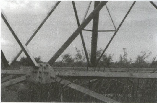
รูปที่ 15 เกิดสนิมมากผิดปกติที่บางชิ้นส่วน
