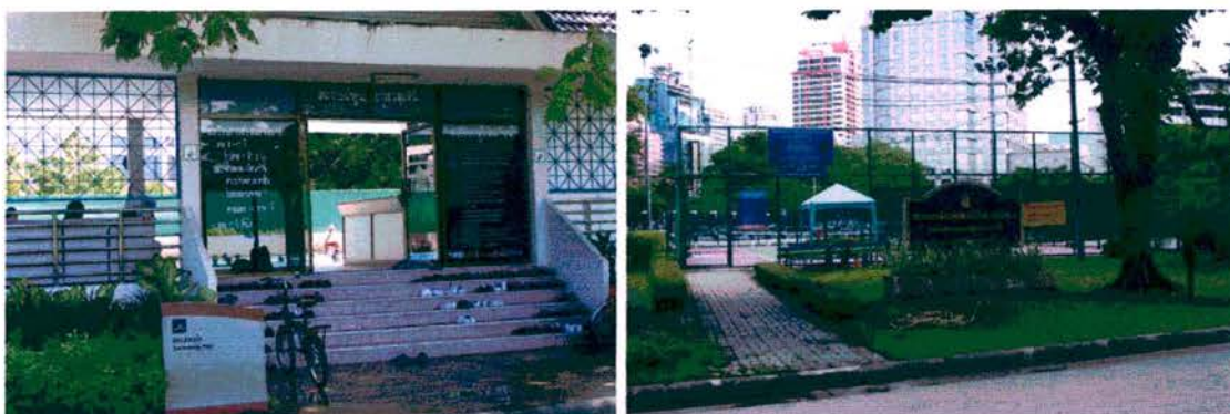
ภาพที่ 3.8 ศูนย์เยาวชนเฉลิมพระเกียรติ ทางด้านทิศใต้ เป็นส่วนของด้านหน้าอาคาร ใกล้กับศูนย์เยาวชนเฉลิมพระเกียรติ ทางด้านทิศตะวันตก เป็นส่วนของห้องสมุดประชาชน กรุงเทพมหานคร
