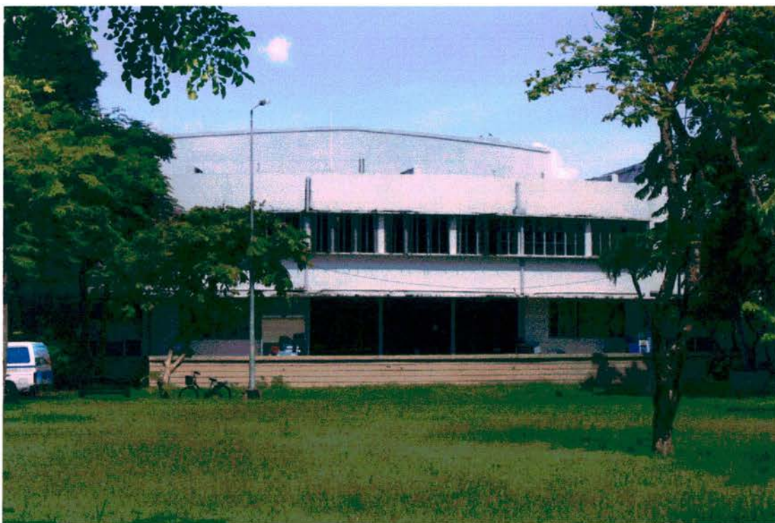
ภาพที่ 3.18 แสดงอาคารทางด้านทิศตะวันตก
