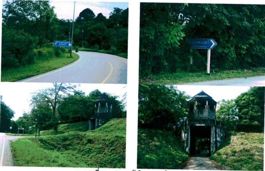
ภาพที่ 3.9 ถนนหน้าโครงการถึงประตูทางเข้า
