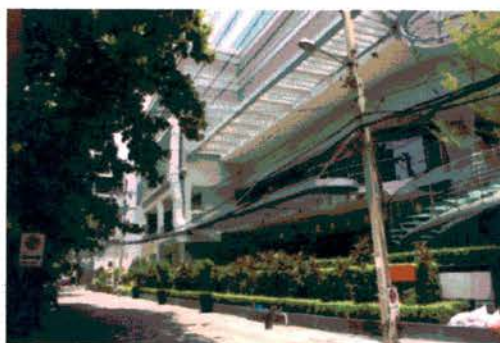
ภาพที่3.14 แสดงการรับรู้อาคาร ที่มา: ภาพถ่าย 1 ส.ค. 53
