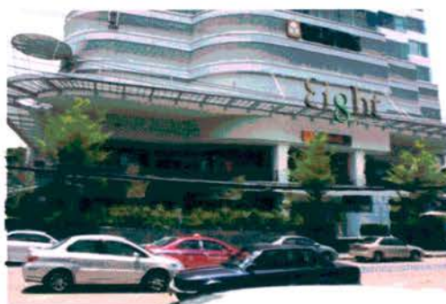
ภาพที่ 1.13 แสดงการรับรู้อาคาร ที่มา: ภาพถ่าย 1 ส.ค. 53
