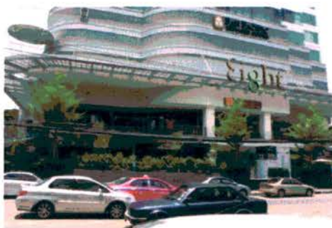
ภาพที่3.13 แสดงการรับรู้อาคาร ที่มา: ภาพถ่าย 1 ส.ค. 53
