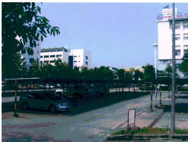
ภาพที่ 3.15 แสดงที่จอดรถของโครงการโครงการ ที่มา: จากการสำรวจสถานที่จริง
