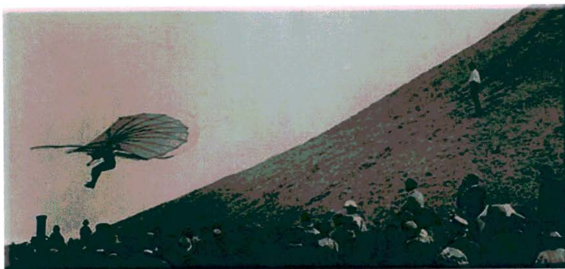
ภาพที่2.21 แสดงเครื่องการทดสอบเครื่องร่อนโดยออตโต ลีเลียนธาล ,1890
