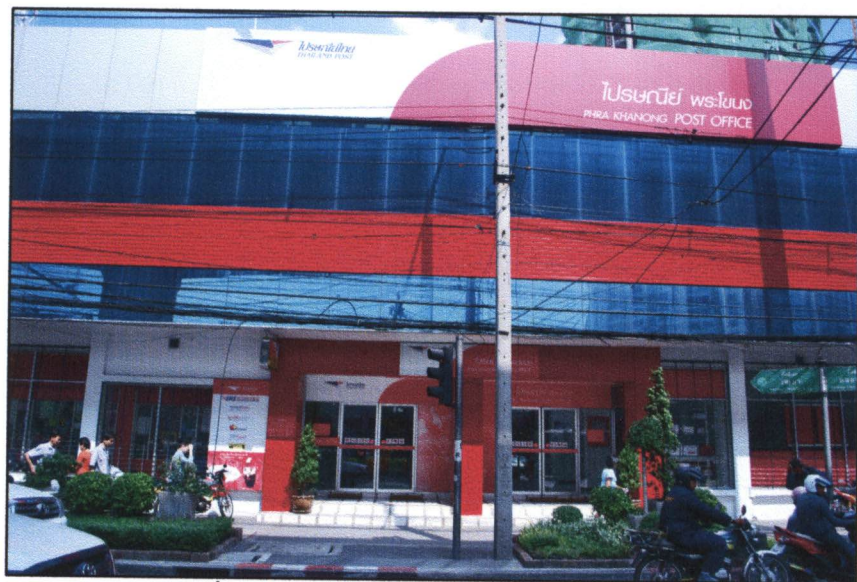
ภาพที่ 4.11 แสดงภาพถ่ายอาคารจากด้านหน้าโครงการ
