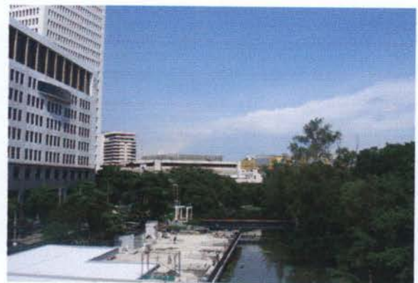
ภาพที่ 3.18 แสดงบริที่จอดรถบริเวณ โครงการ
