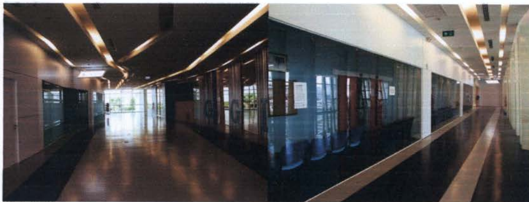
ภาพที่ 3.37 แสดงไฟฟ้าส่องสว่างแบบซ่อนไฟ
