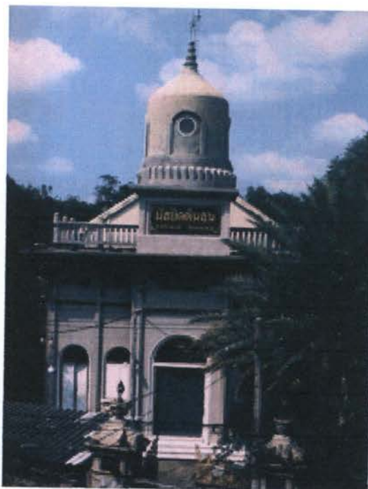
ภาพที่ 2.41 แสดงภาพอาคารหลังปัจจุบัน
