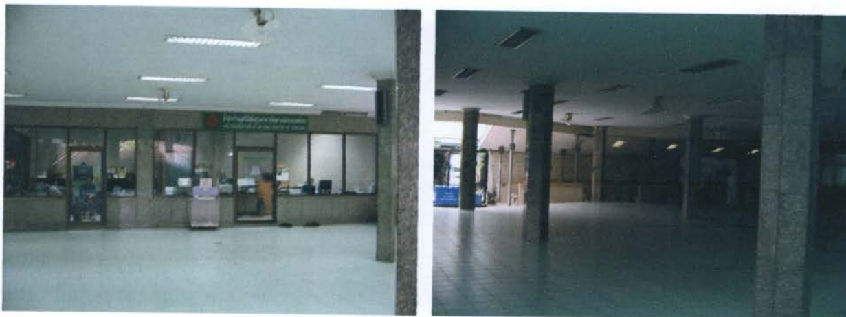
ภาพที่ 3.4 แสดงภาพภายในส่วนลานอเนกประสงค์ด้านล่าง ที่มา ; ภาพถ่ายจากการวิเคราะห์สถานที่จริง
