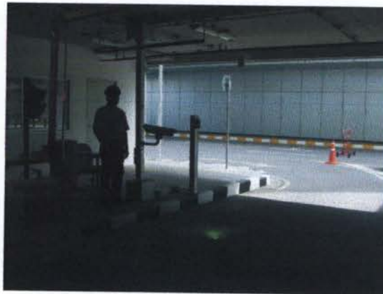
ภาพที่ 3.13 ทางเข้าอาคารจอดรถ
