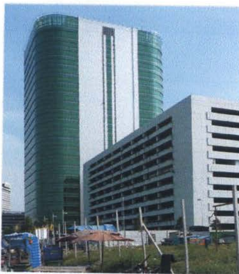
ภาพที่ 3.14 อาคารจอดรถ P1
