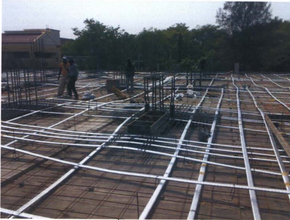
วางสลิงตามแนวที่วิศวจะได้คำนวณการรับน้ำหนักไว้
