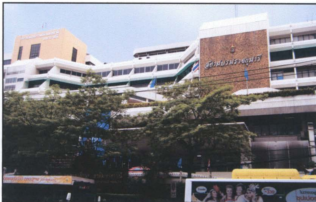
ภาพที่ 3.2 : แสดงสภาพอาคารที่ตั้ง
