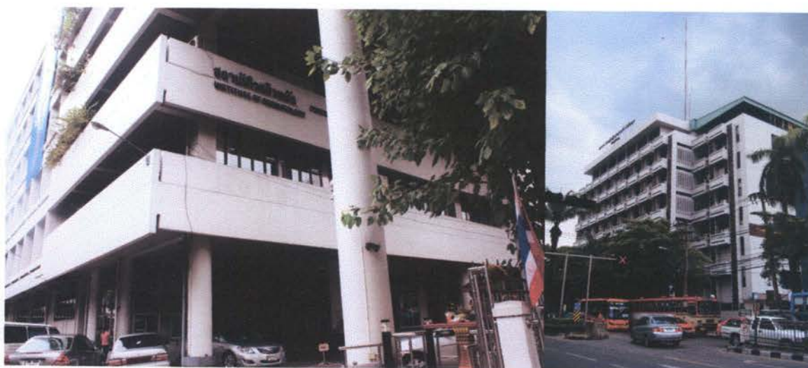
ภาพที่ 3.4 : แสดงสภาพสภาพแวดล้อมที่ตั้งอาคาร
