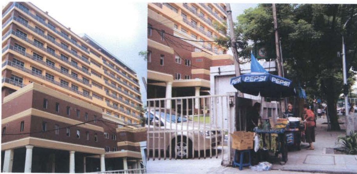
ภาพที่ 3.6 : แสดงสภาพสภาพแวดล้อมที่ตั้งอาคาร
