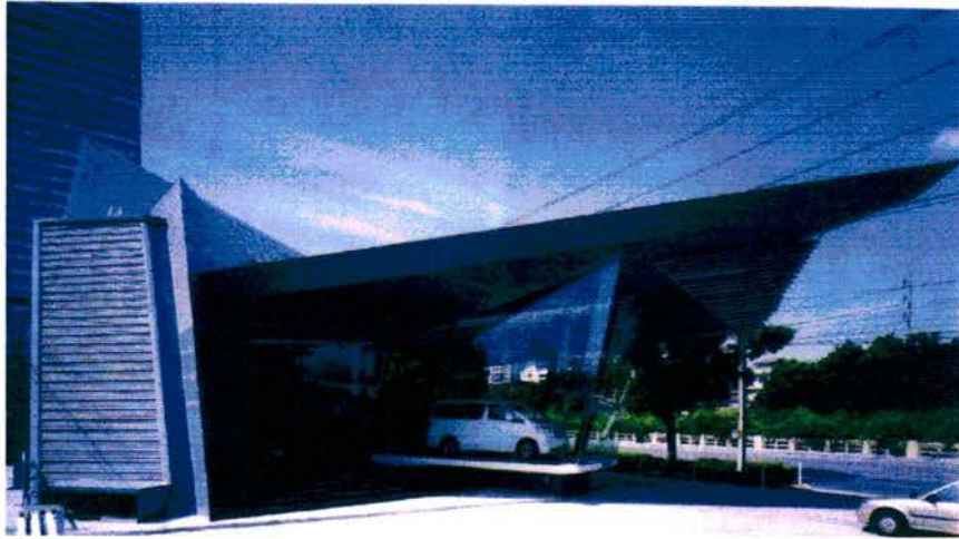
ภาพที่ 2.65 แสดงภายนอกอาคาร 1
