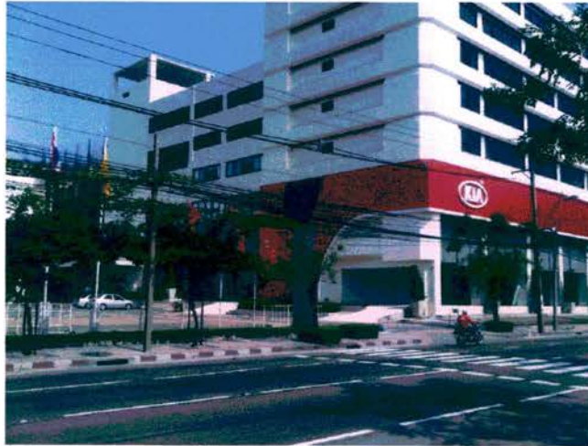
ภาพที่ 3.11 แสดงภาพทางเข้าอาคาร
