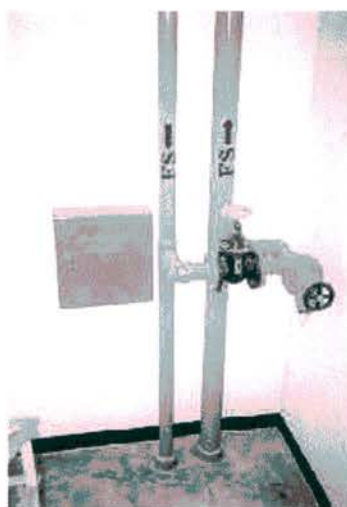
ภาพที่ 2.9 ภาพแสดงท่อส่งน้ำดับเพลิง
