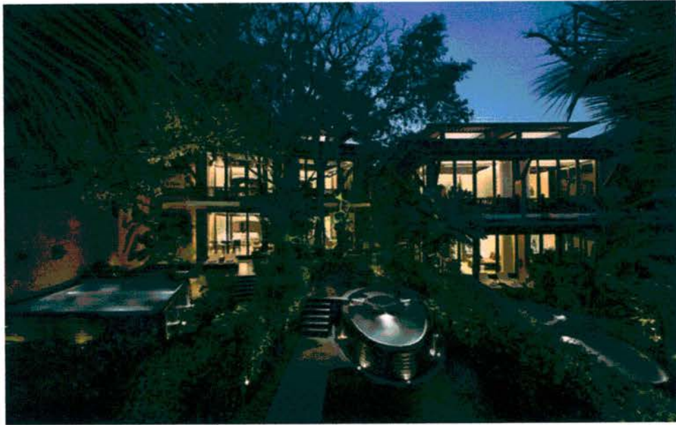
ภาพที่ 2.12 ภาพแสดงตัวอาคาร เดอะบาราย
