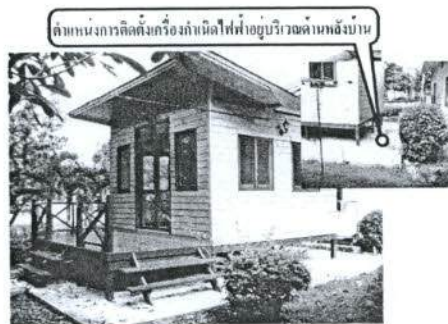
(ค) สถานที่ติดตั้งเครื่องกำเนิดไฟฟ้าขนาด 3.5 kW ที่ใช้ไบโอดีเซลเป็นเชื้อเพลิง
