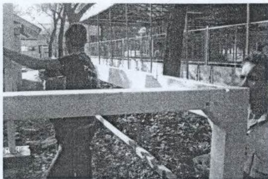
รูปที่ 15 การติดตั้งฐานราก, เสา, กาน
