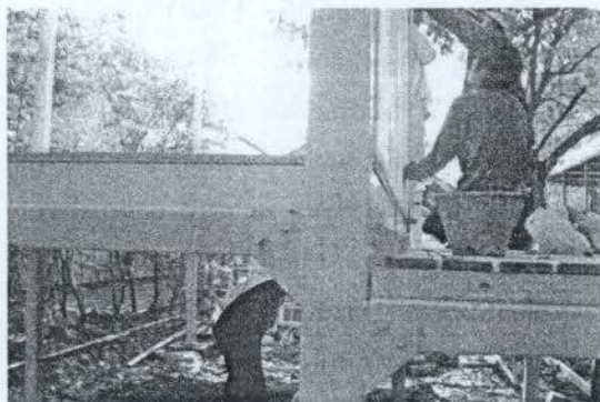
รูปที่ 16 การติดตั้งคานส่วนที่พัก และชานระเบียง
