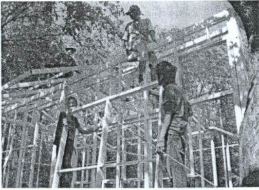
รูปที่ 19 การติดตั้งส่วนโครงหลังคา
