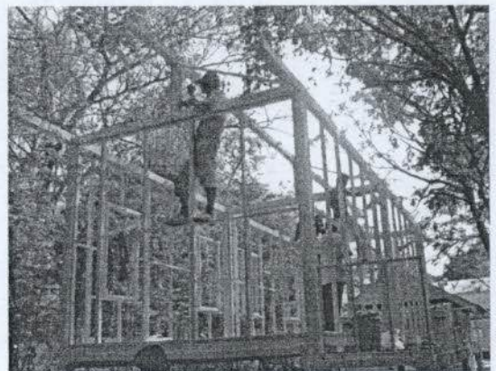
รูปที่ 18 การติดตั้งเสา, อกไก่, อะเสสกัค
