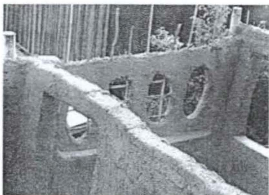
รูปที่ 17 ดินอุ้มน้ำไว้มาก จนทำให้อ่อนตัวเสียรูป (ที่มา : www.baandin.com )
