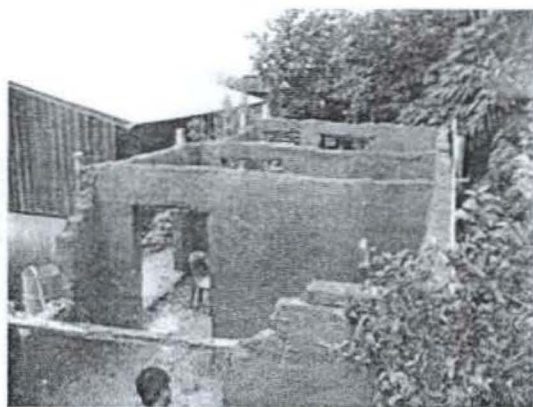
รูปที่ 16 ผนังดินพังเนื่องจากฝนตกหนักติดต่อกันหลายวัน (ที่มา : www.baandin.com )
