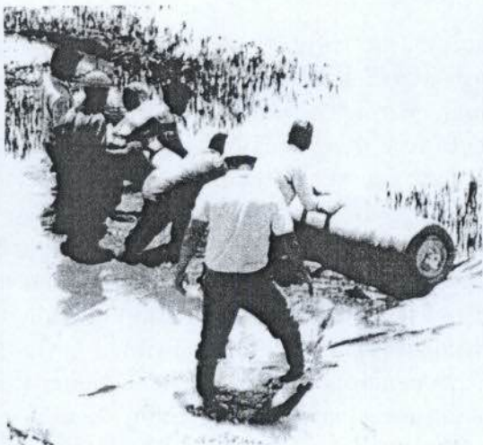
รูปที่ 8 การปูแผ่น Polyfelt บนชั้นดินที่น้ำท่วมเจิ่งนอง โดยไม่ต้องปรับพื้นก่อน
