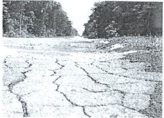
รูปที่ 2 ความเสียหายทรุดเป็นร่องเนื่องจากการทรุดตัวของโครงสร้าง
