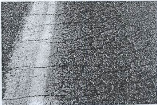
รูปที่ 5 ความเสียหายลักษณะแตกกลายหนังจระเข้
