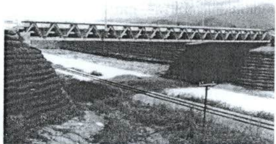
รูปที่ 15 การเสริมแรงด้วย Polyfelt rock PEC ของคอสะพานสูง 12 ม. พ่นปิดด้วยยางมะตอยเพื่อกันแสงแดด
