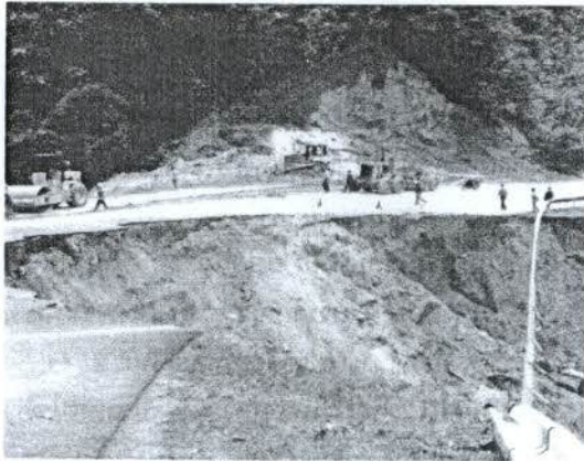
รูปที่ 11 การพังทลายของหน้าดินที่สามารถปรับปรุงได้ง่าย โดยใช้ Polyfelt
