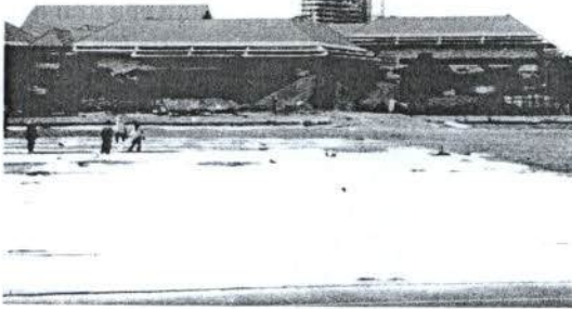
รูปที่ 10 การปู Polyfelt ในงานสนามกีฬาโรงเรียนนานาชาติ SBN
