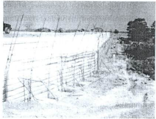
รูปที่ 14 คั่นดินเสริม Polyfelt rock PEC สูง 6 ม. ลาดเอียง 85-90 องศา
