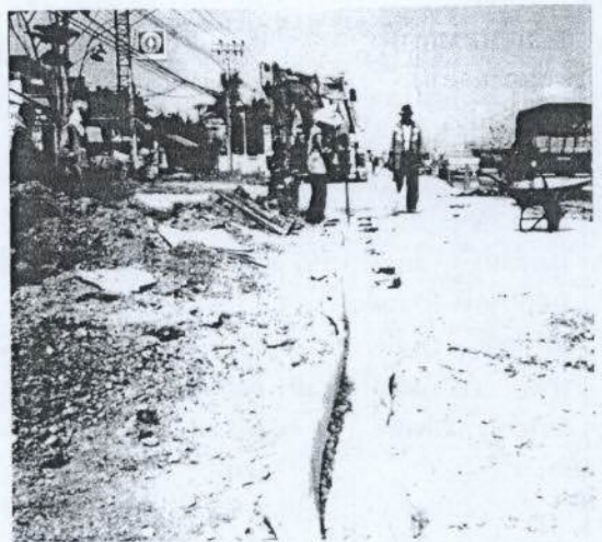
รูปที่ 9 การสร้างทางระบบระบายน้ำข้างถนน
