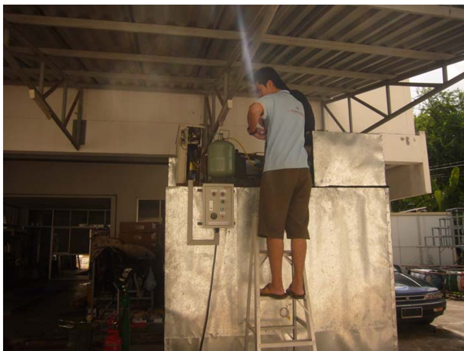
ภาพที่ ก.5 การเติม R-22 เข้าระบบปั๊มความร้อน
