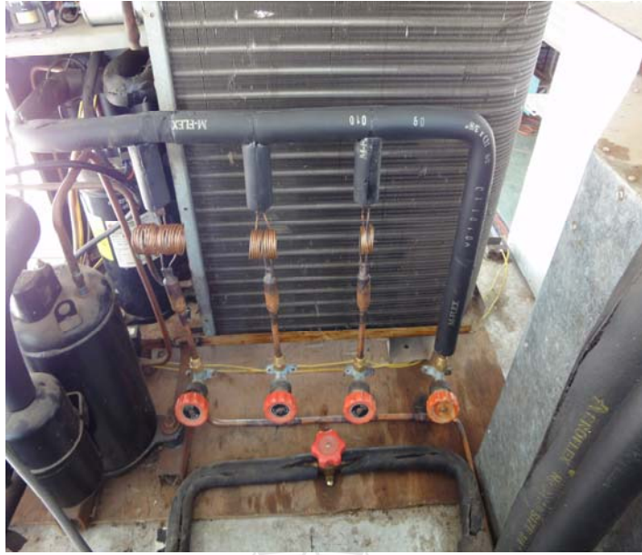
ภาพที่ ก.11 การติดตั้งอุปกรณ์ปรับลดความดันขนาดความยาวต่างของระบบปั๊มความร้อน
