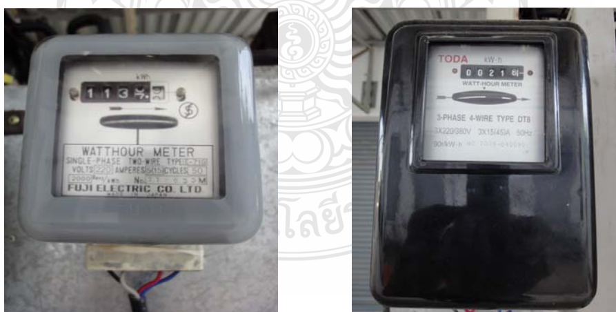
ภาพที่ 3.9 การติดตั้งกิโลวัตต์ชั่วโมงมิเตอร์
