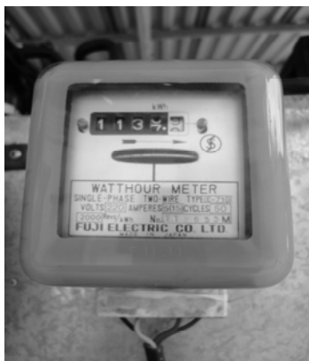
ภาพที่ 5 มาตรวัดกำลังไฟฟ้ากิโลวัตต์ชั่วโมงมิเตอร์
