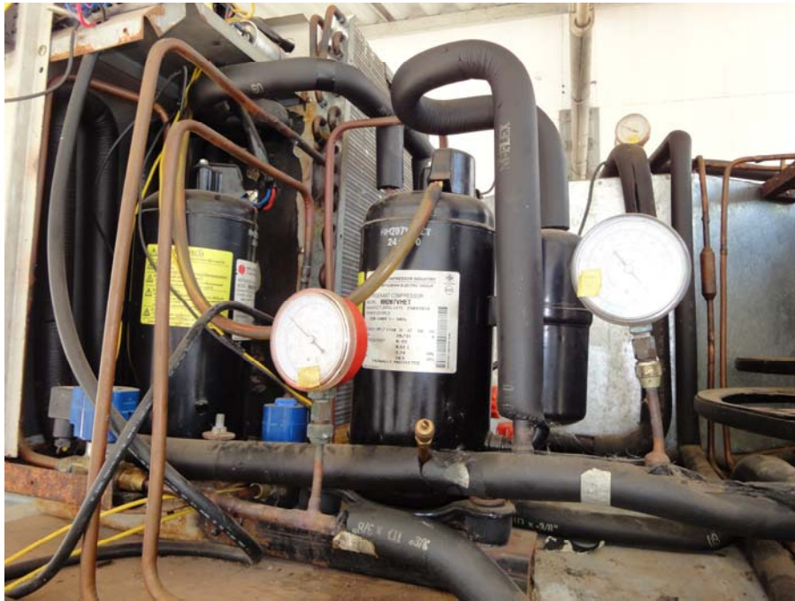
ภาพที่ ก.5 การติดตั้งเกจวัดความดันในระบบปรับอากาศ
