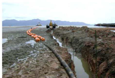
รูปที่ 1 การวางสายเคเบิลใต้น้ำ
