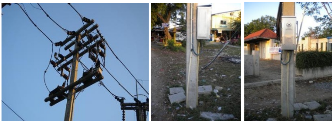
ภาพที่ 3.1 การติดตั้งมิเตอร์อ่านหน่วยอัตโนมัติ
