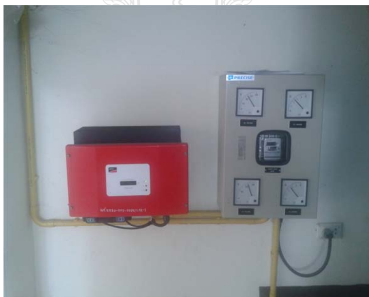
ภาพที่ 3.2 อินเวอร์เตอร์และมิเตอร์ในระบบเซลล์แสงอาทิตย์
